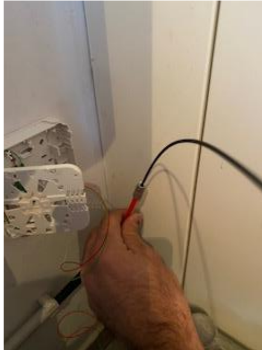
2. Kabel einblasen
