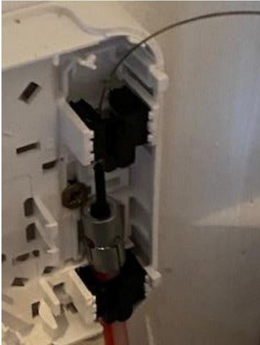
5. Abfangung einsetzen
