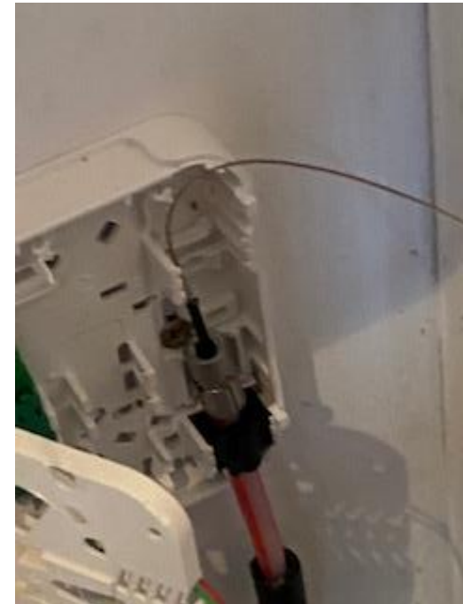
4. Abfangung montieren
